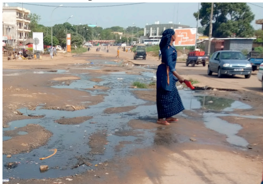
Photo 7: Le ruissellement d'eaux usées sur la voie au quartier Dioulakro
