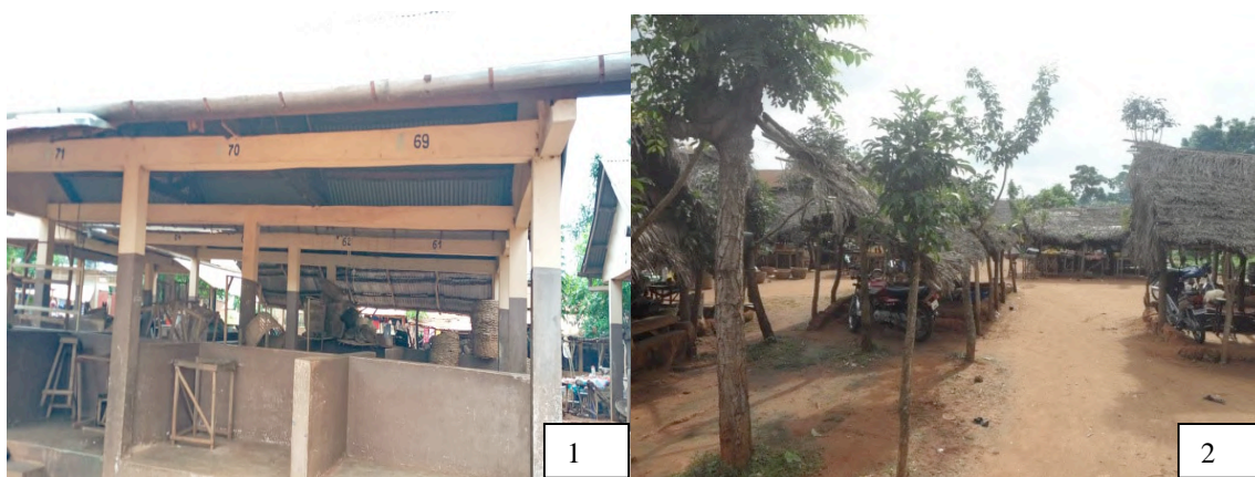
Photo 1 : Hangar moderne dans le marché de Kpétu
